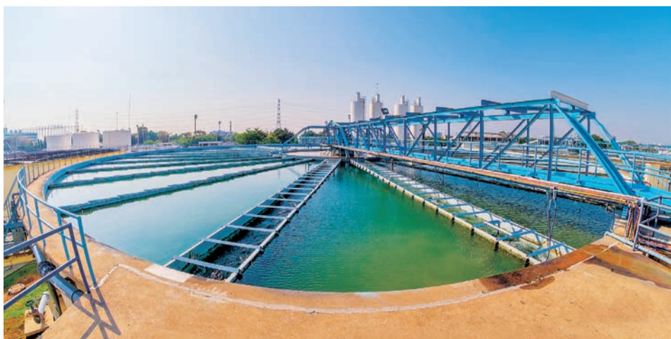
Очистные сооружения, Московская область
